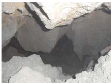
图 4 ZK67+835 处揭露溶洞
