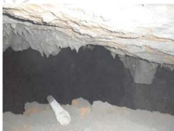
图 8 YK67+805 处揭露溶洞
